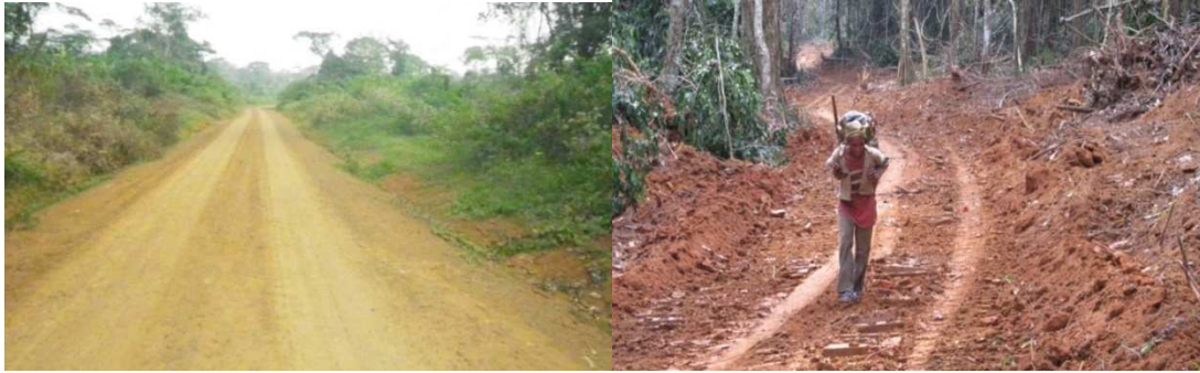
Aménagement des pistes agricoles
