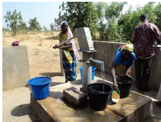
Photo 10 : Forage réhabilité à Kalliao
