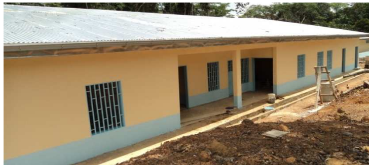
Locaux du Centre des Services Agricoles de Meyomessi
