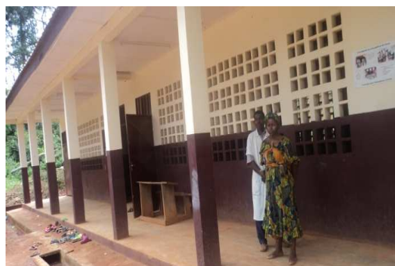
Nouvelle salle de classe à l'EP d'Oding
