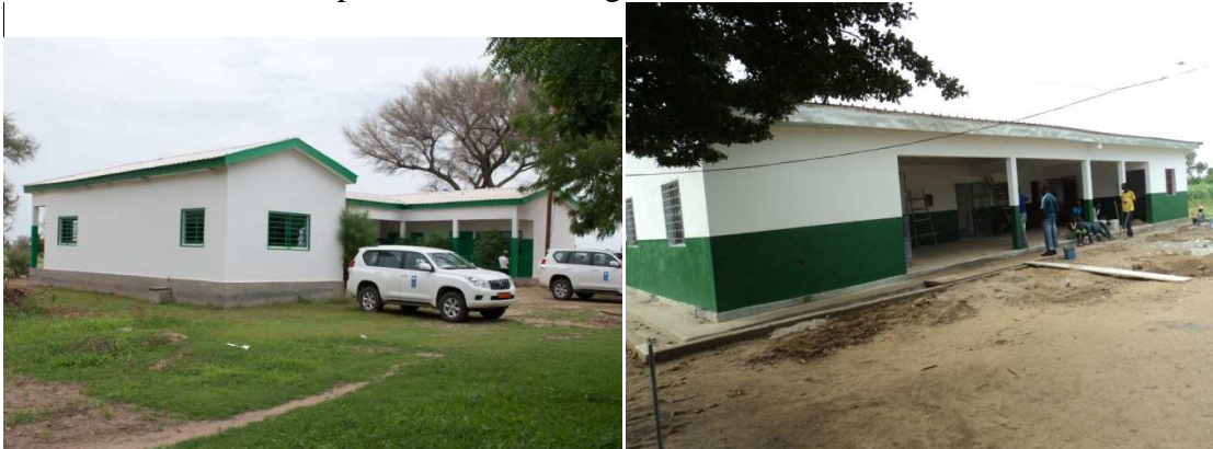
Centres de santé intégré de Kalliao et Meskine rénovés dans la commune de Maroua 1 er
