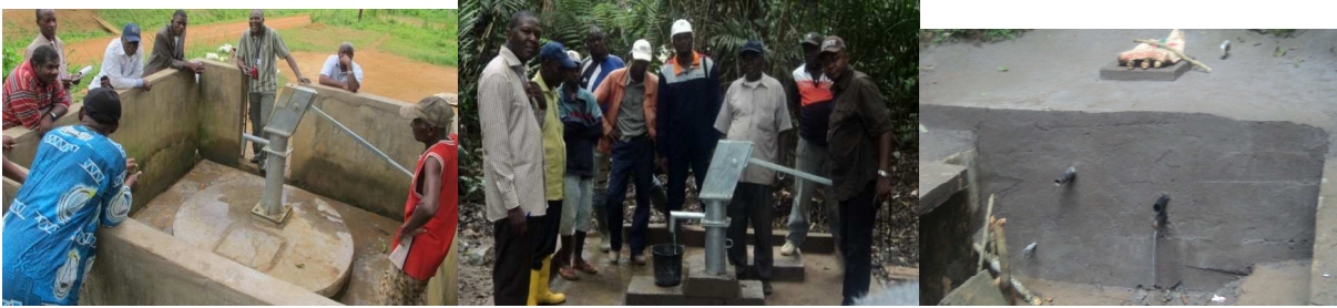
Puits réhabilité à Ndjele
